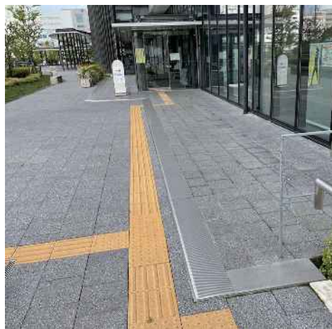
誘導ブロック設置
