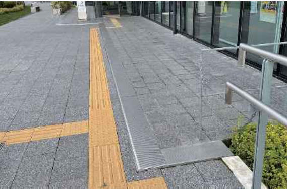
インターロッキング・EXP.J金物・誘導ブロック
