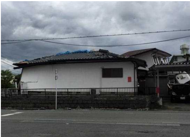
地震により亀裂の入った建物
