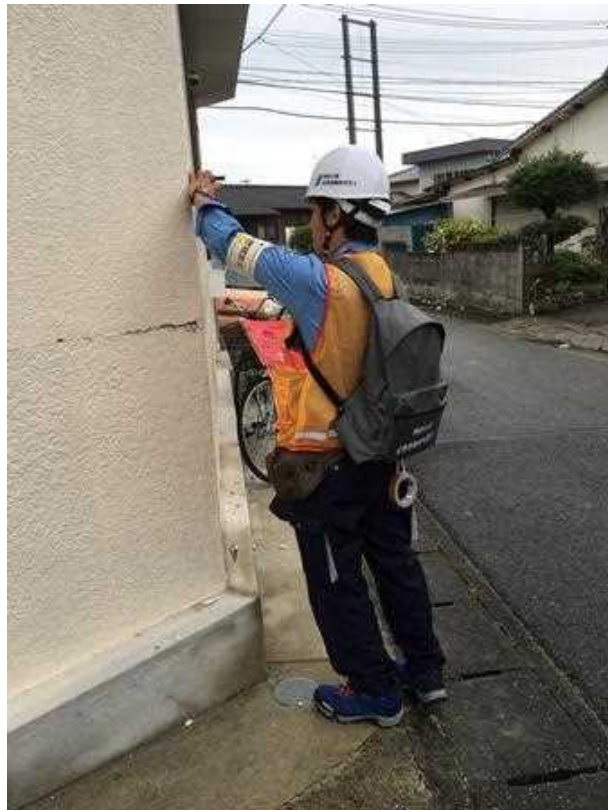
傾きや亀裂などを確認
