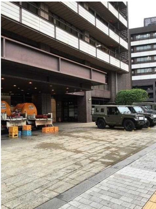
熊本市役所前の様子
