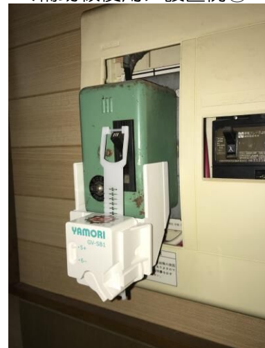
＜補助板使用＞設置例②
