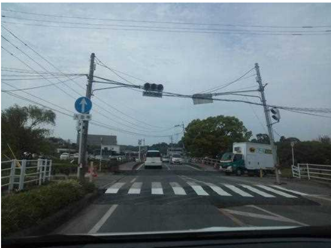
道路は隆起し、信号も倒れ掛かっている
