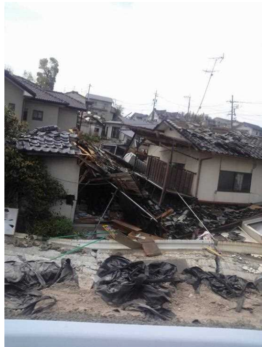
倒壊している被災地の家屋
