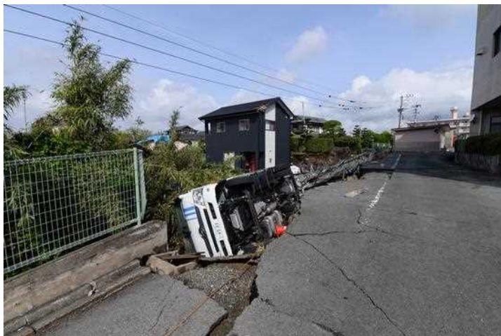
地割れで横転したトラック
