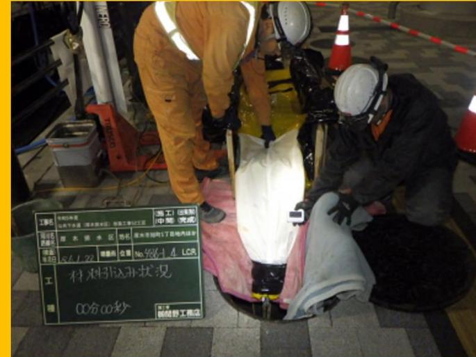
既設管の内側に新たな管材を挿入
