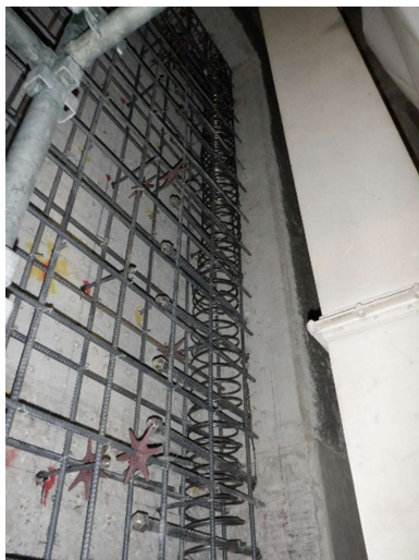
写真 3-7 自家発電室 耐震化施工状況
