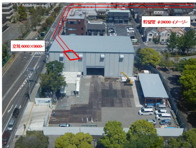
写真 3-4 雨水貯留管整備状況 (厚木中央公園)
