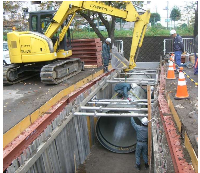
写真 3-1 浸水対策施設の整備
