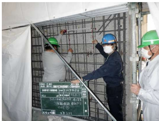
写真 3-7 自家発電室 耐震化施工状況
