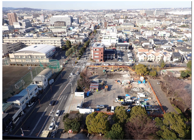
2023年2月(施工ヤード片付け・立坑埋戻中)
