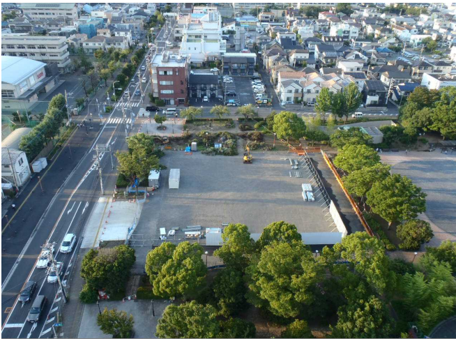
2020年8月(仮囲い及び整地施工中)
