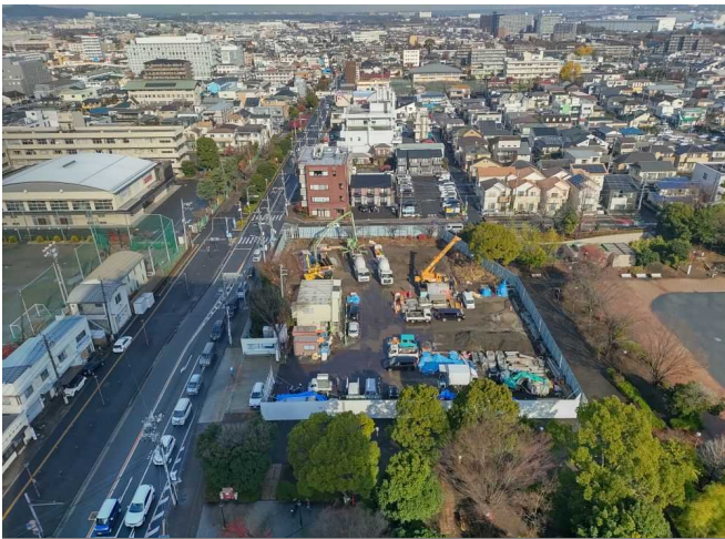
2023年1月(返送ポンプ人孔施工中)
