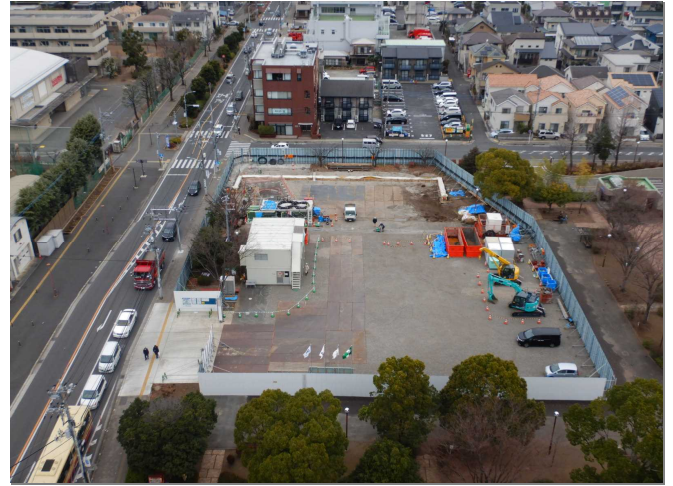
2021年1月(防音ハウス基礎を施工中)
