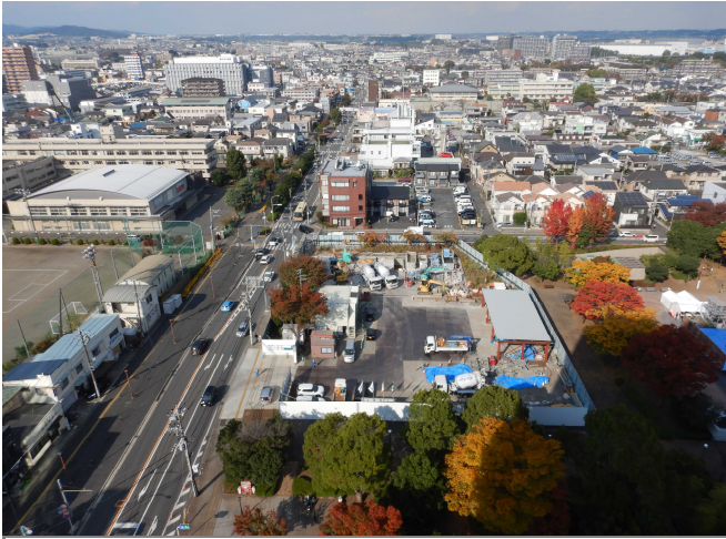
2022年11月(二次覆エコンクリート施工中)
