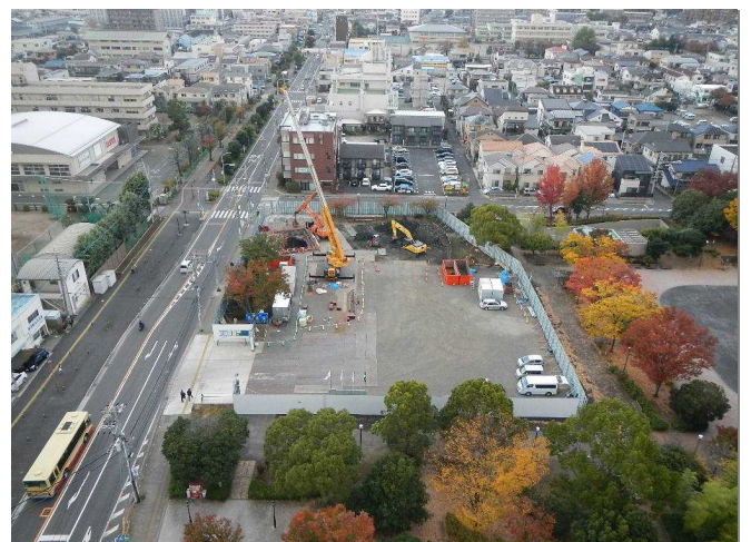
2020年11月(立坑掘削工施工中)
