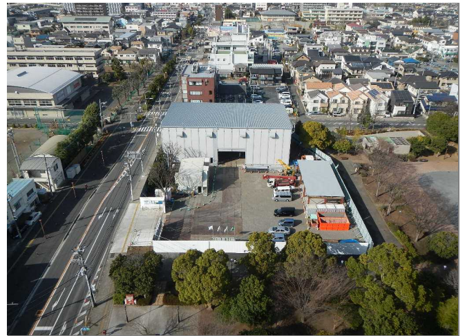
2021年3月(防音ハウス完成)
