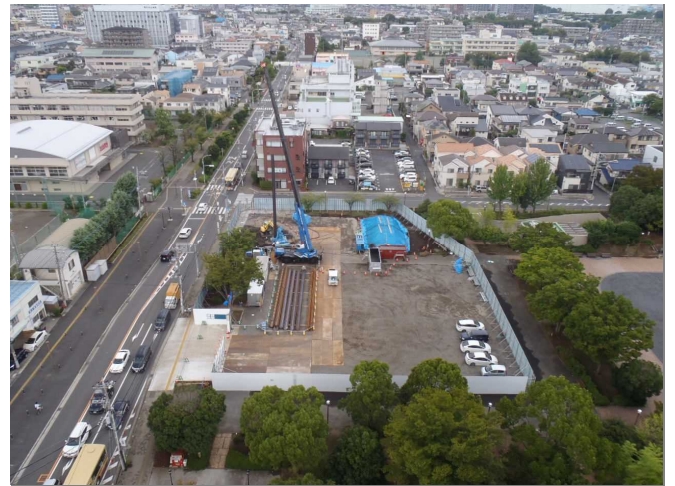
2020年9月(土留工施工中)
