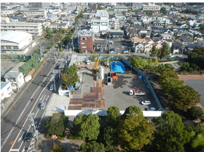
2020年10月(地盤改良工施工中)
