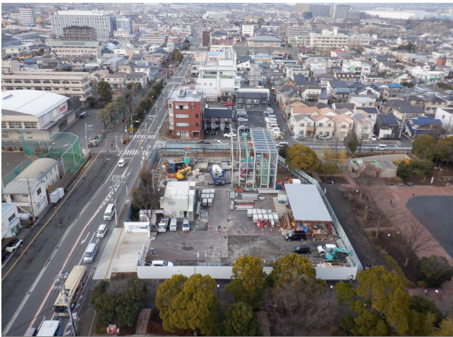
2022年2月(防音ハウス解体中)
