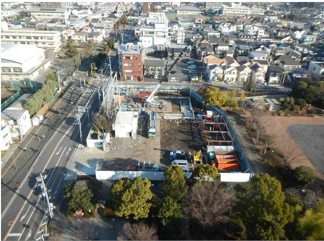
2021年2月(防音ハウス本体を施工中)
