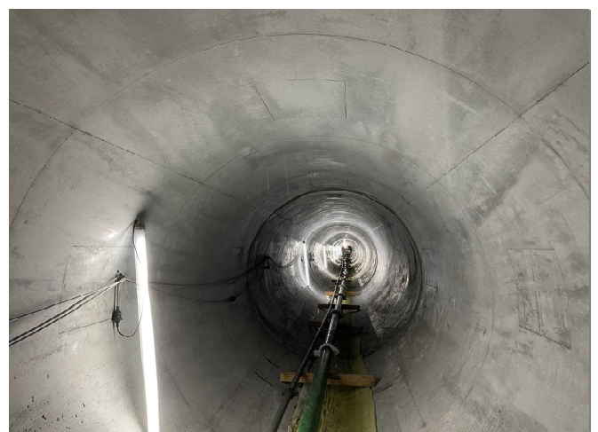
2022年6月(二次覆工施工中)
