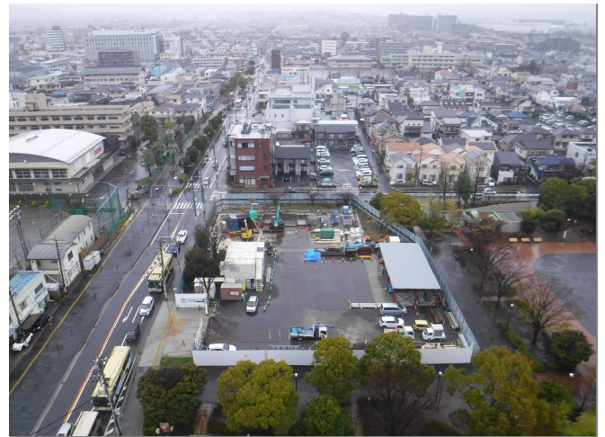
2022年3月(防音ハウス解体完了)
