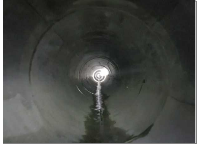
2022年11月(二次覆エコンクリート完了)
