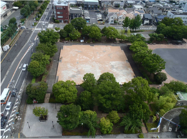
2020年6月(工事着手前)
