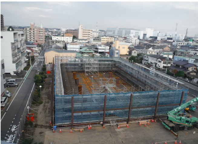
2017年11月(1ロット躯体構築施工中)
