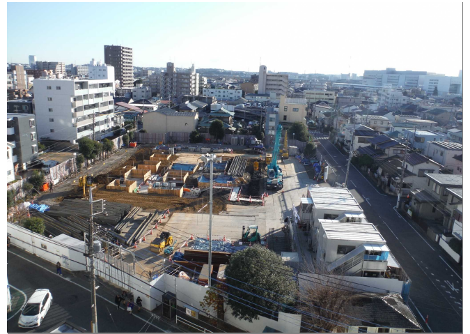
2019年1月 (防護鋼矢板撤去)
