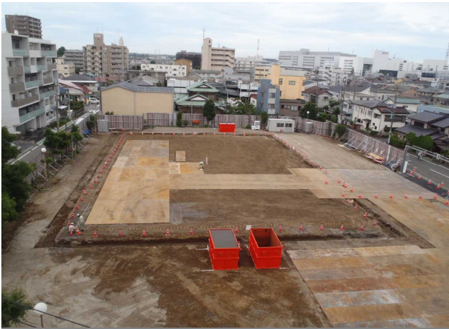
2017年6月(公園撤去工完了・防護鋼矢板施工前)
