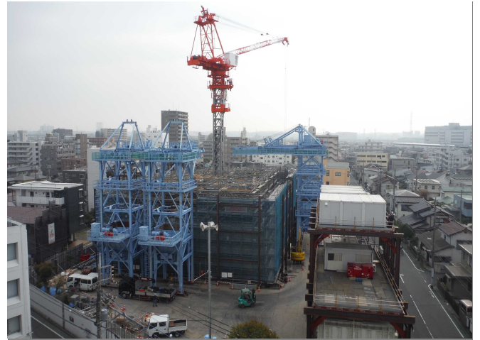
2018年4月 (3ロット躯体構築施工中)
