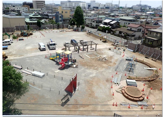
2017年5月(公園撤去工施工中)
