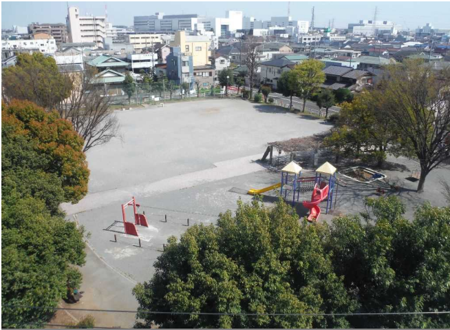
2017年4月(工事着手前)
