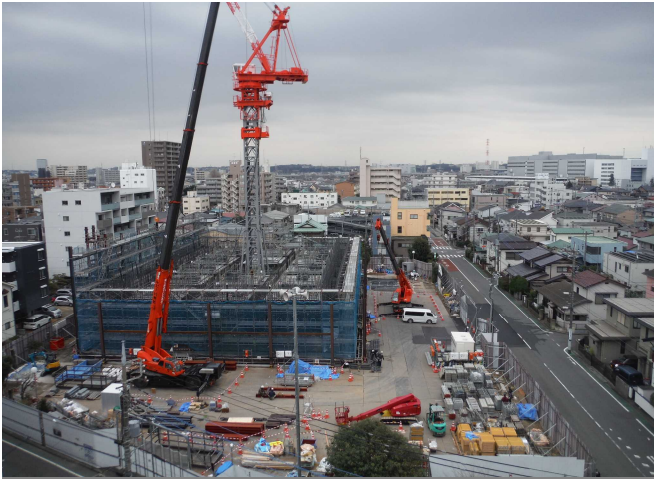
2018年2月 (2ロット躯体構築施工中)
