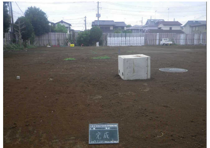
2019年8月 (雨水貯留施設完成)
