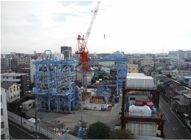
2018年10月 (躯体構築および沈下完了)
