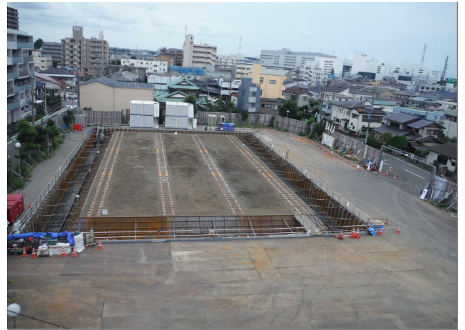
2017年10月(砂セトル完了・刃口金物施工中)
