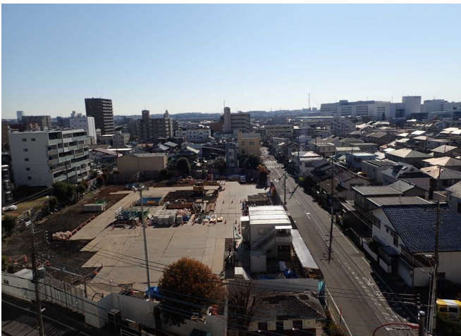
2019年4月 (導水管および分水人孔施工中)
