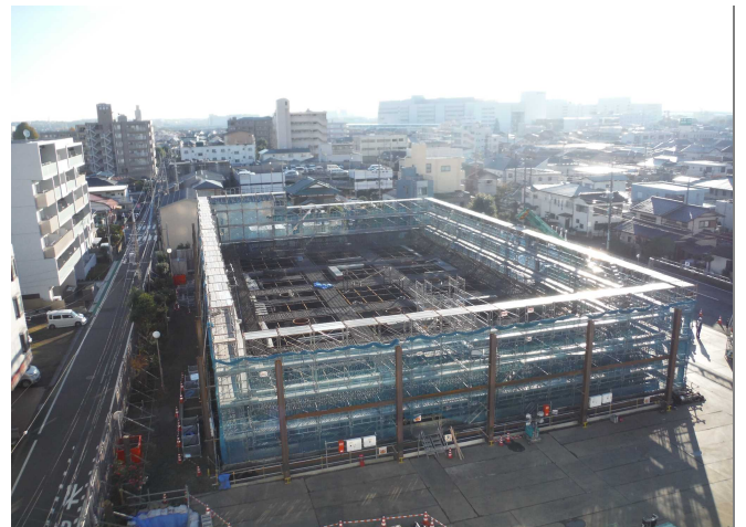
2017年12月(1ロット躯体構築施工中)
