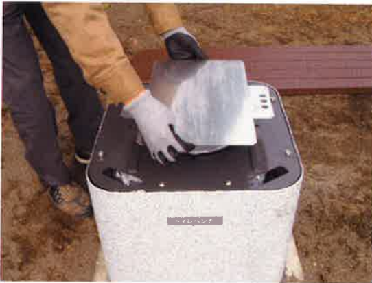
③雨水止板を外す。
