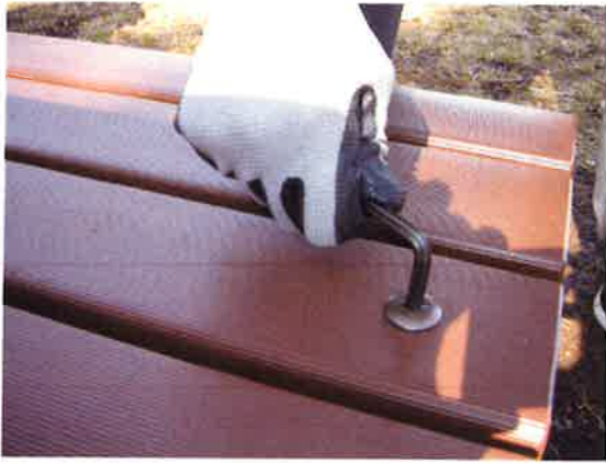
①専用工具で2ヶ所のビスを外し、
