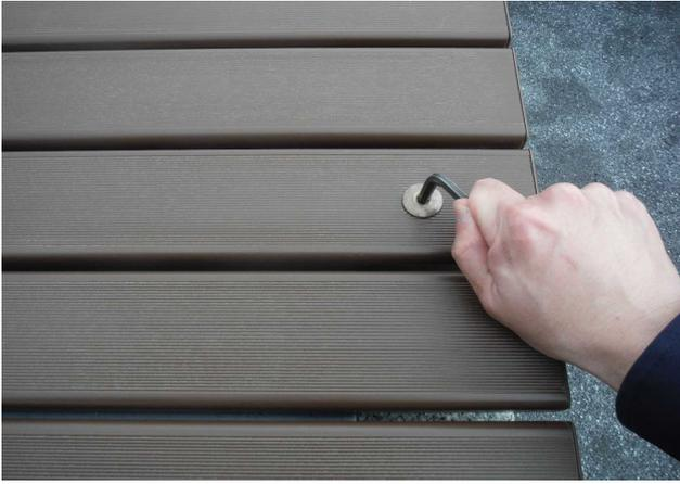
①専用工具で2ヶ所のビスを外します。
