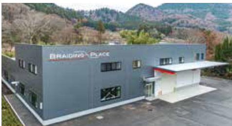
システム建築工場新築工事
