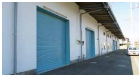
厚木工場外観
