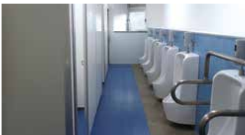
中学校トイレ改修
