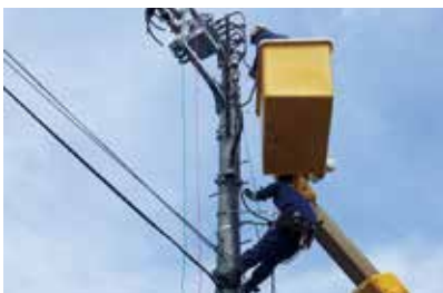
高圧改修工事
