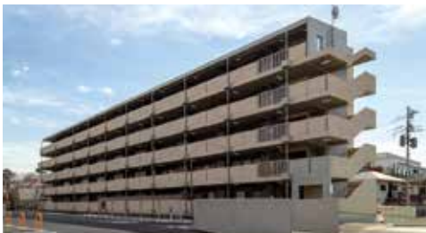
厚木市市営住宅新築工事
