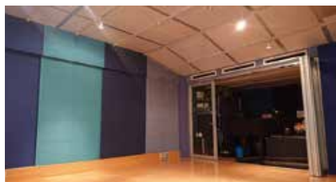
音楽スタジオ天井施工
