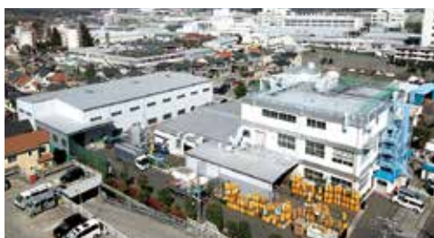
厚木工場外観
