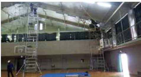
体育館照明改修工事
