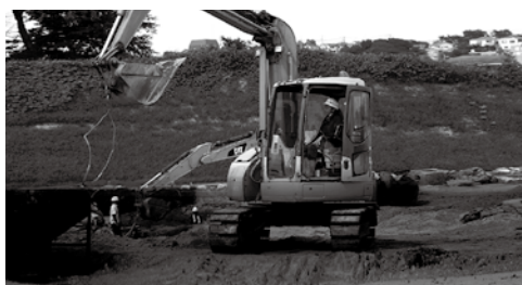
現場作業風景
