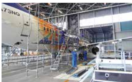
特殊な足場施工
