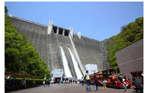
愛川町にある宮ヶ瀬ダムは絶好の周遊地
