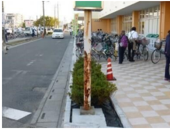
支柱の腐食が進行した状態
