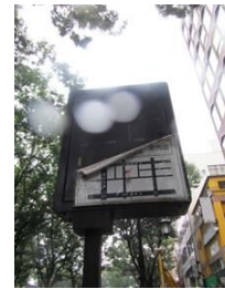
シート材がはがれかかった状態
