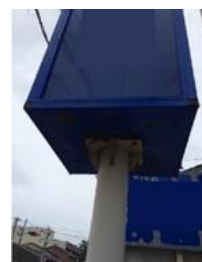
支柱・広告板接合部
