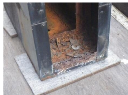
底部が腐食していた看板の例
