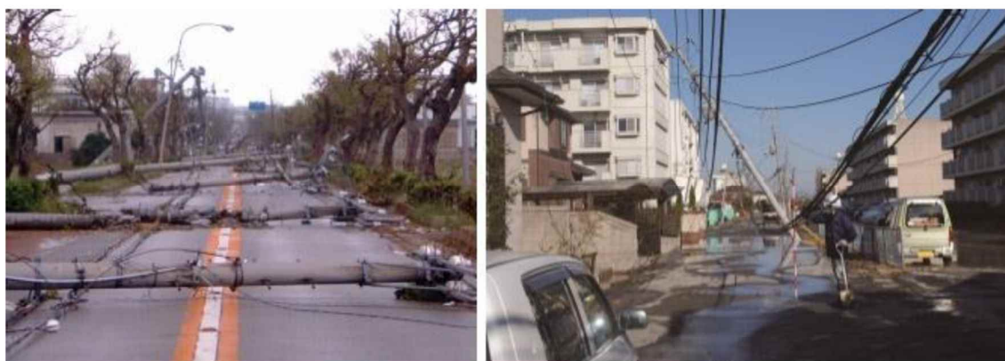
【災害時の救護活動を妨げる電柱】
