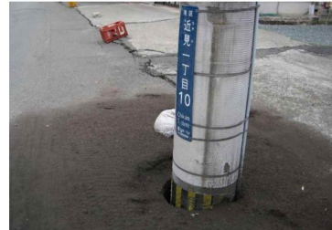
【電柱の沈下】
