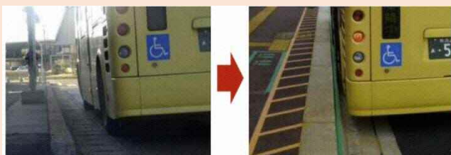
△施工前(平均離隔 50 cm) △施工後(平均離隔 10 cm)
