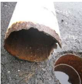
ポール看板の倒壊
