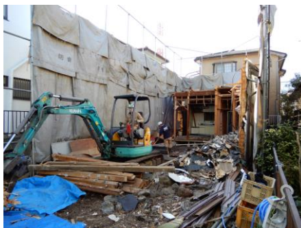
■ 空き家の解体イメージ
