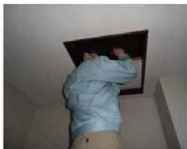
「小屋組・梁」調査の様子
