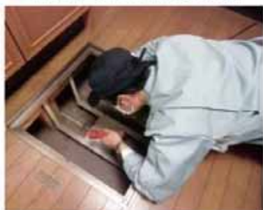
「土台・床組、基礎」調査の様子
