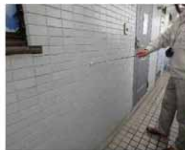
「外部（外壁）」調査の様子
