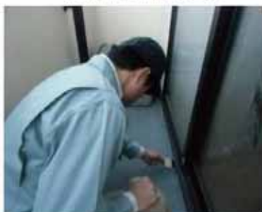
「外部（バルコニー）」調査の様子
