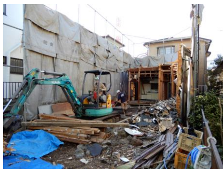
■ 空き家の解体イメージ
