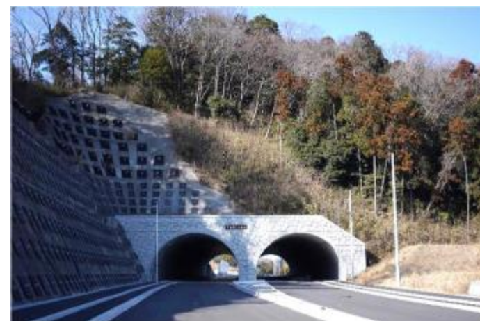
整備が進む厚木環状3号線（上下とも）
