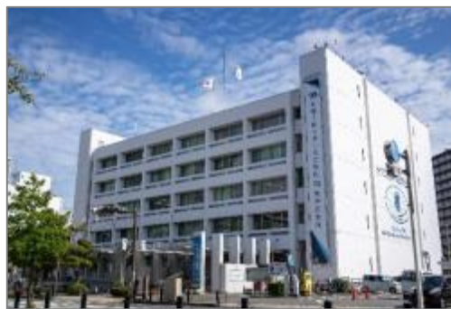
図 2 厚木市役所本庁舎
