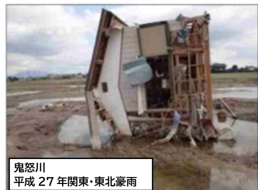
堤防決壊による家屋の倒壊
