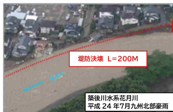
侵食により家屋が流出した状況
