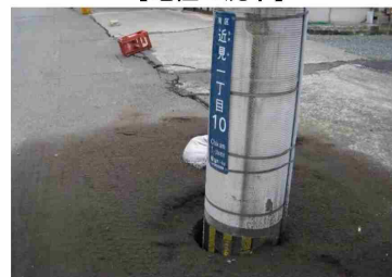
【電柱の沈下】
