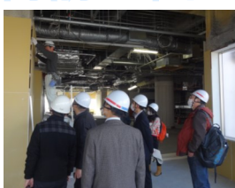
□建築現場視察
