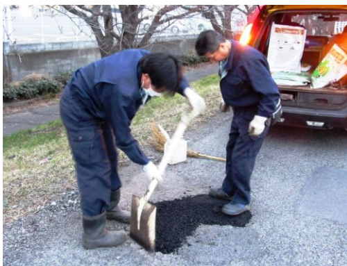
職員による舗装の補修
