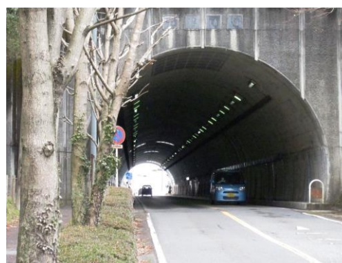
トンネル(七沢隧道)
