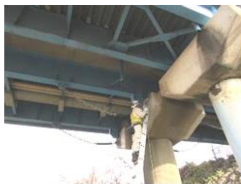
橋梁点検の実施状況(鮎津橋)
