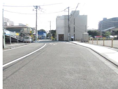
中町立体駐車場地先
