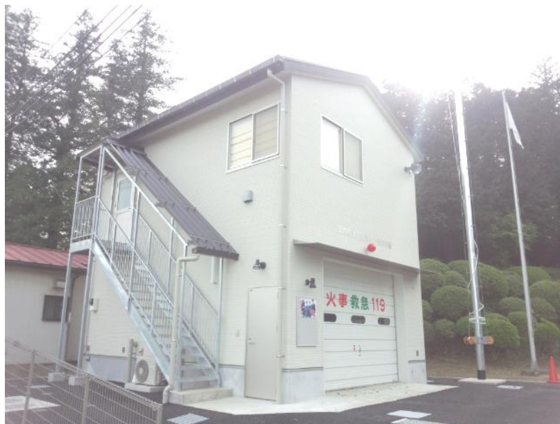
器具置場完成写真
