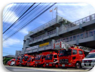
消防本部庁舎
