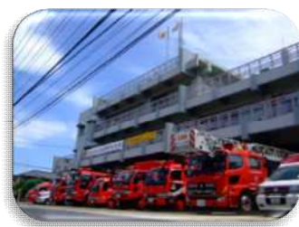
消防本部庁舎
