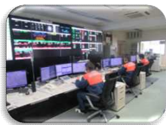
高機能消防指令センター
