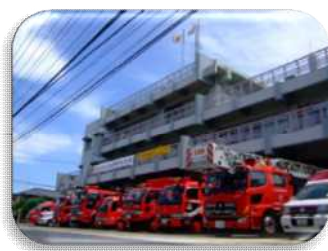
消防本部庁舎
