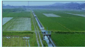
【農業用排水路】
