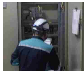
自動制御機器点検
