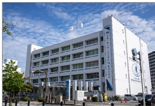
図 2 厚木市役所本庁舎
