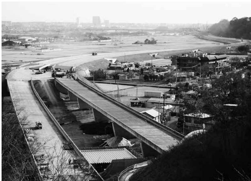
整備が進むさがみ縦貫道路（上依知小学校から座架依橋方面を望む）。中依知には（仮称）圏央厚木インターチェンジの設置が予定されている
