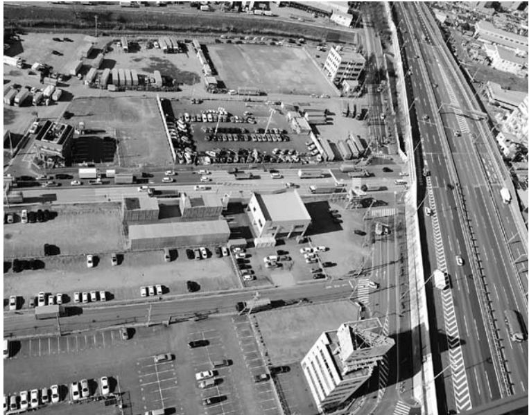
東名厚木インター付近の大型商業施設建設予定区域(右は東名高速道路、中央を国道129号が横断)。11月に一部開業が予定されている
