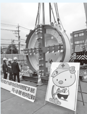
シールドマシンなどの現場説明会
