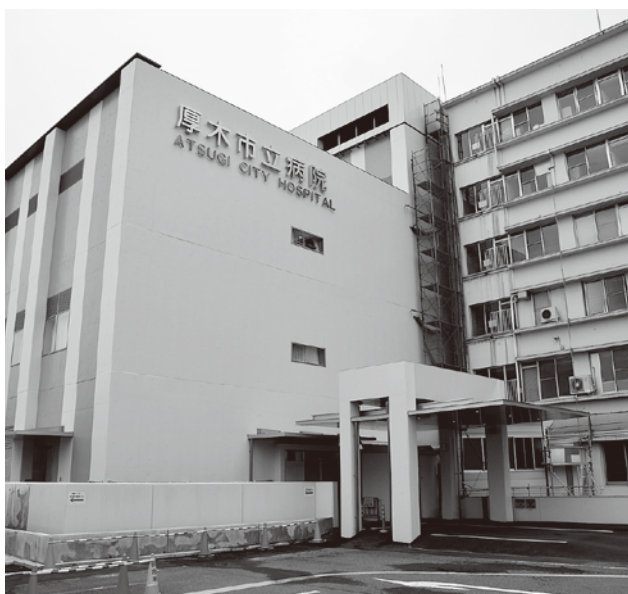
第Ⅰ期工事が完了し、医療機能の70%が稼働している新市立病院。平成29年春に全面オープンが予定されている。
