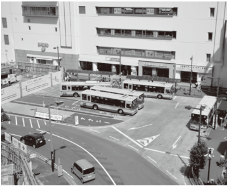
2020年の完成を目指し、工事が進められている本厚木駅南口ロータリー
