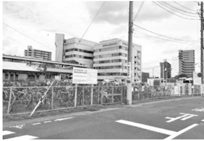
中町第2-2地区にある複合施設建設予定地
