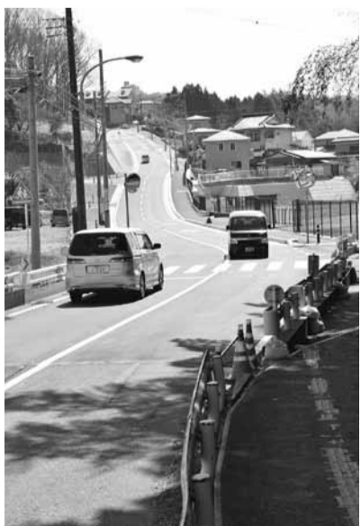
完成が期待される新斎場周辺の道路(下古沢)
