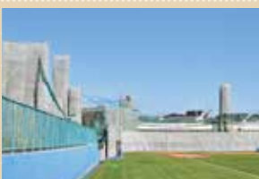
改修工事が進む及川球技場
