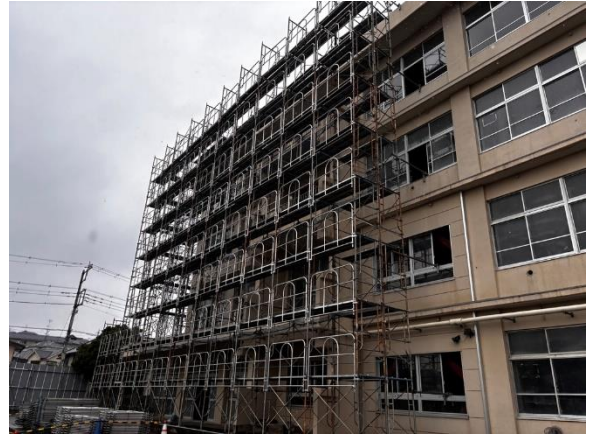
西棟外部足場を撮影
