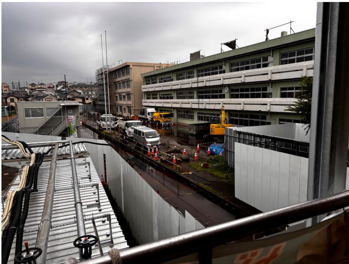
工事エリア内から撮影
