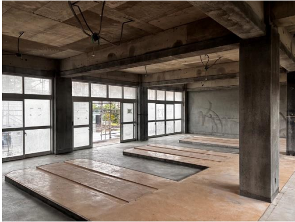
西棟昇降口を撮影
