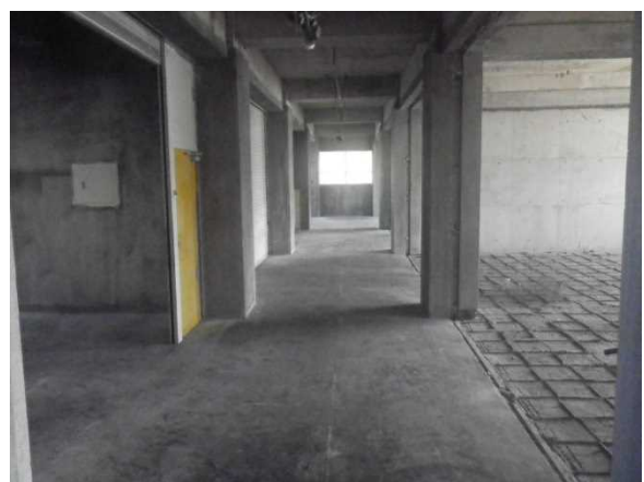
西棟廊下を撮影
