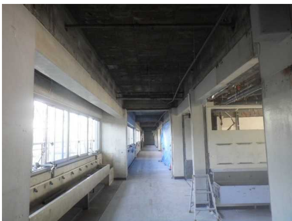
中央棟廊下を撮影
