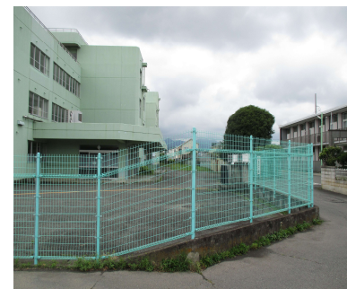
⑨北棟北側通路
