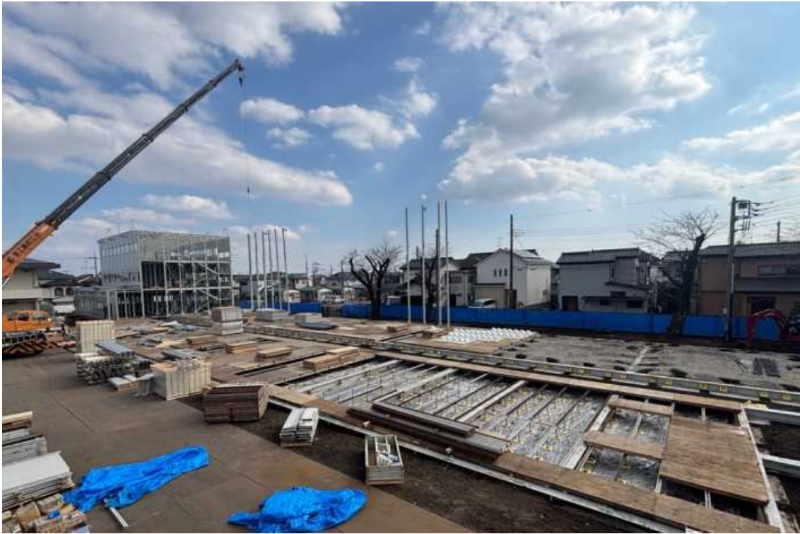
仮設事務所から撮影
