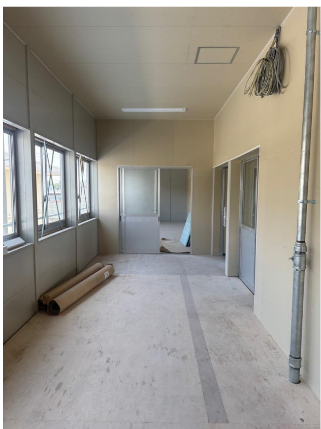
3階廊下を撮影 ・壁のボード貼りが完了しました。
