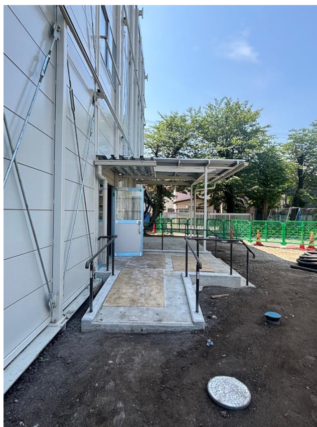
西側出入口を撮影
