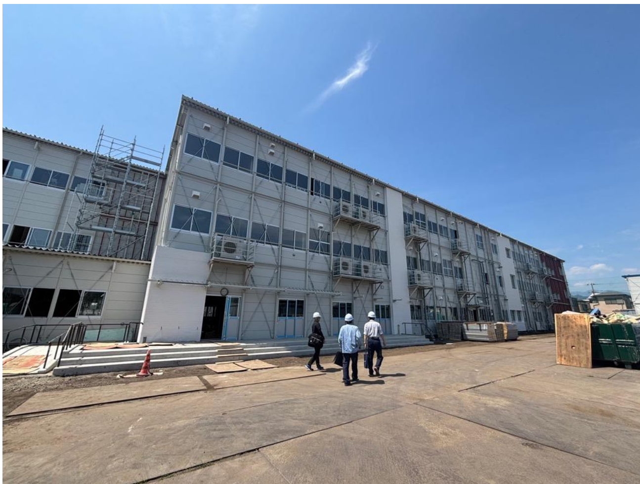
工事現場内を撮影
