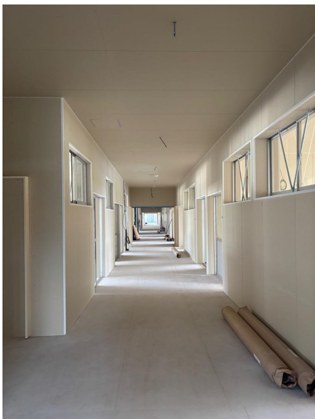
2階廊下を撮影 ・壁のボード貼りが完了しました。
