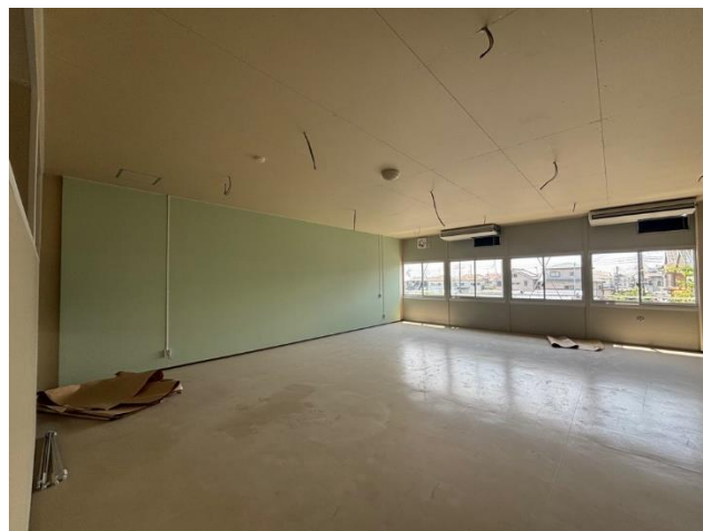
普通教室を撮影 ・壁のボード貼りが完了しました。
