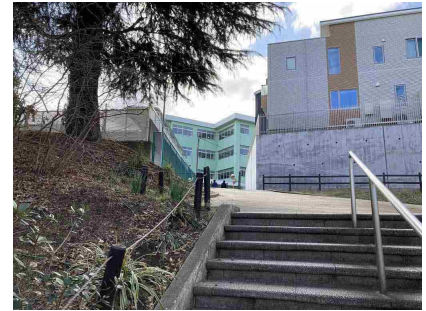
⑥プール脇の階段からの西棟
