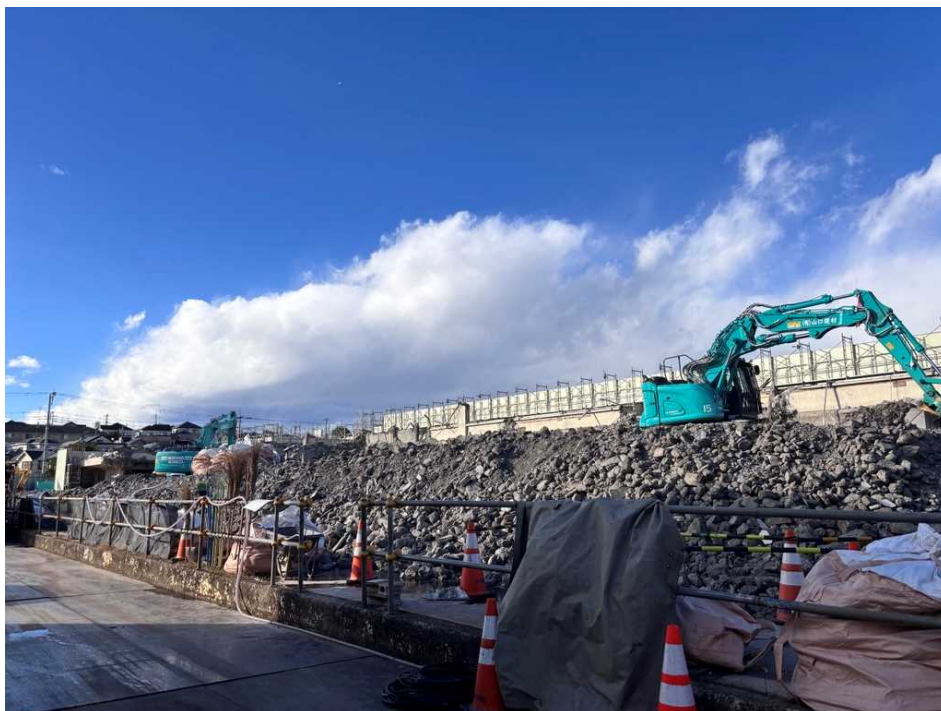
中央棟校舎解体状況を撮影
