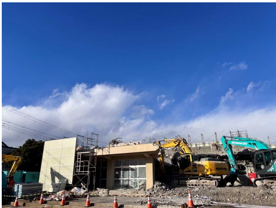
西棟校舎解体状況を撮影
