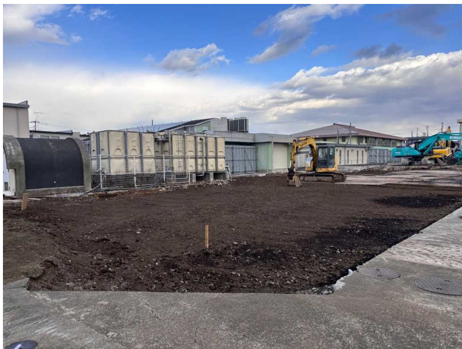
西棟校舎解体状況を撮影
