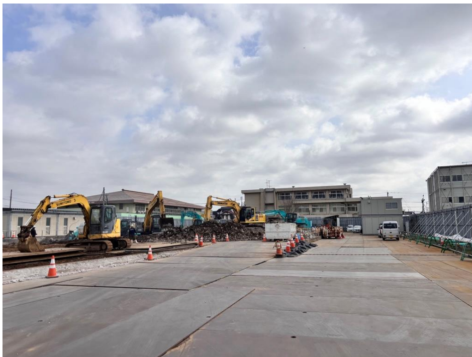
中央棟校舎解体状況を撮影
