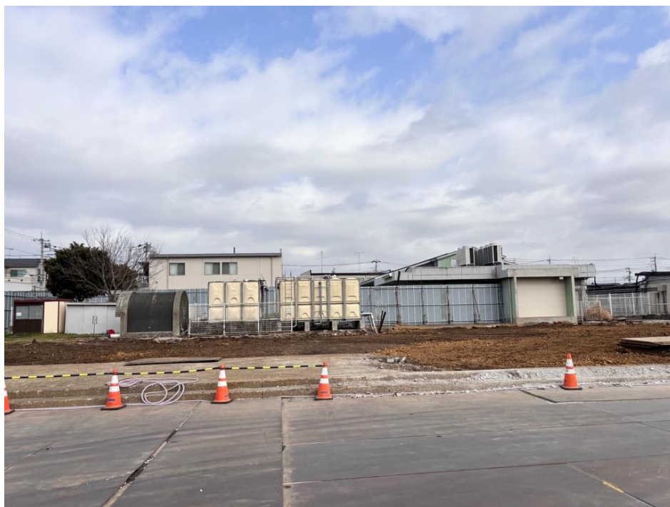
西棟校舎解体状況を撮影
